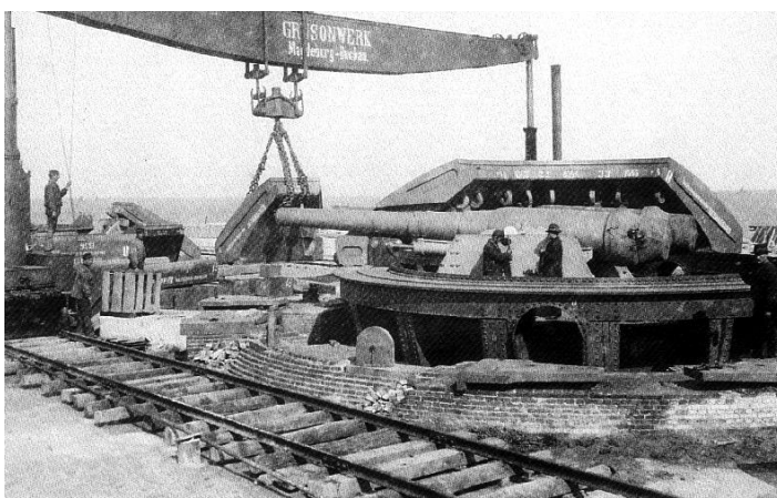
De oostelijke koepel in aanbouw, 30 april 1892.
