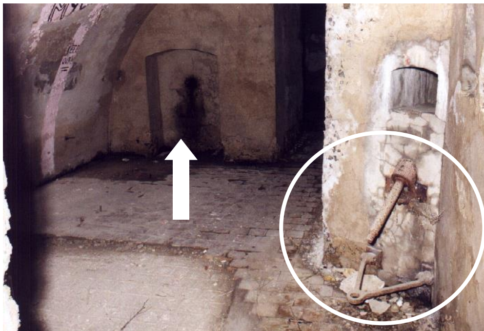
Wachtlokaal in de oostelijke koffer met rechts (zie cirkel) onder het schietgat de restanten van een M90 kazemat-affuit
