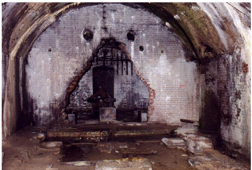
75. De machinekamer waarin twee stoomketels hebben gestaan met een doorkijk naar de dynamokamer. Hierin stonden twee stoommachines waarop twee dynamo's waren aan- gesloten. Die dynamo's werden alleen voor de ver- lichting gebruikt.
