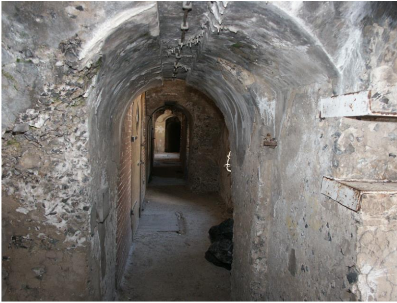
64. Doorkijk in de galerij van de contrescarpmuur vanuit het wachtklokaal, waar je het fort binnenstapt, richting weste- lijke ingang contrescarpgang.
