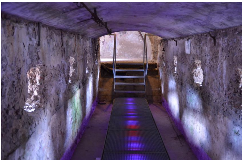
74. Zicht op de zuidelijke ingang van de zuidelijke poterne.
