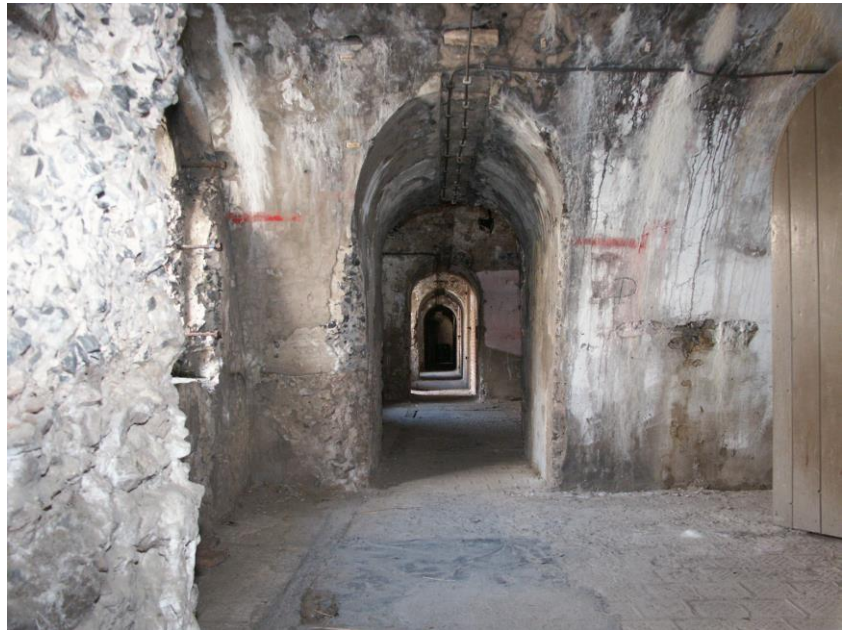
73. Galerij in de contrescarp- muur kijkend in oostelijke richting.
